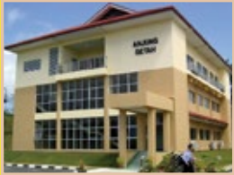
马来西亚沙巴州拿笃区的马来西亚棕榈油总署 (MPOB) 三层办公楼
